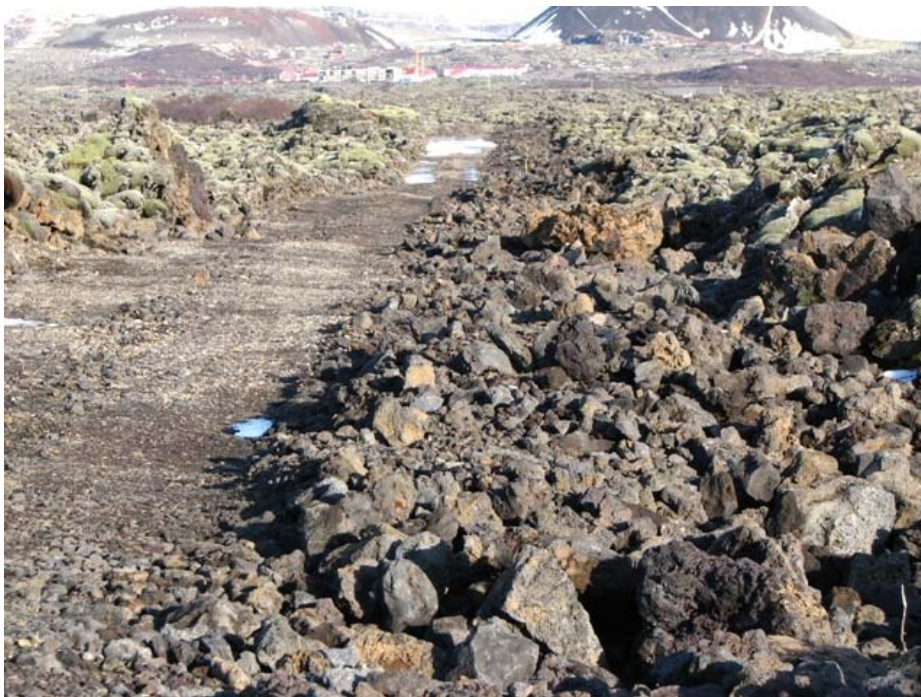
Mynd 44 Ummerki eftir kaldavatnslögn um ósnortið hraun
