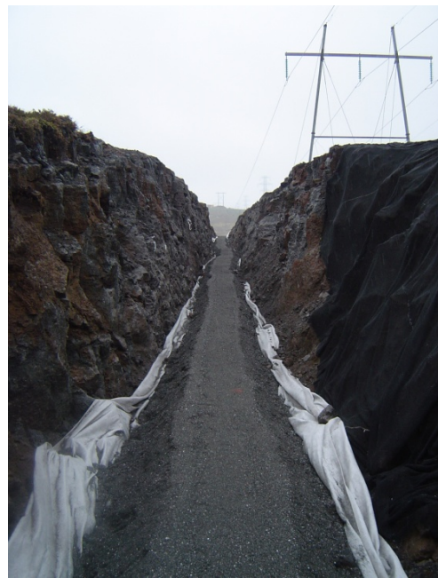
Mynd 13 Strenglögn þar sem taka þurti tillit til framtíðar hæðarkóta
