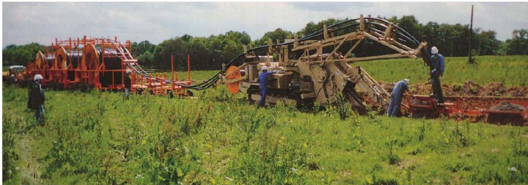
Mynd 31 Þrír einleiðarar plægðir niður samtímis
