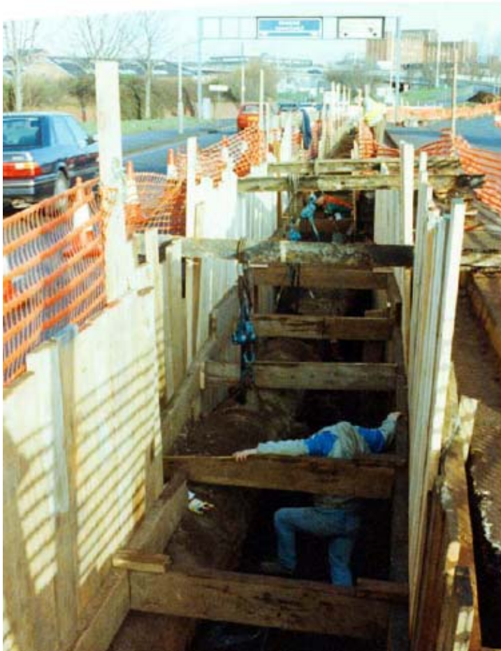
Mynd 41 Strenglögn meðfram umferðaræð
