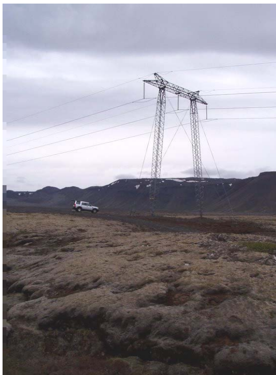
Mynd 2 M-mastur í Búrfellslínu 3B
