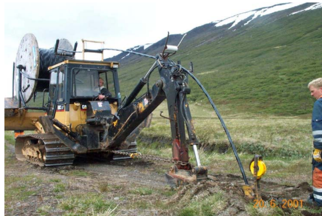
Mynd 10 11 kV strengur í dreifbýli plægður í jörðu
